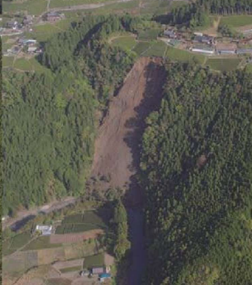
崩壊後(2013年4月23日)
