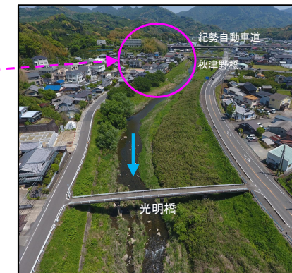
【流下能力不足箇所：光明橋上流付近】
