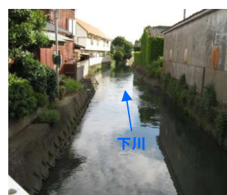
写真 1 - 3 下川 巽橋付近 下川1.1k付近
