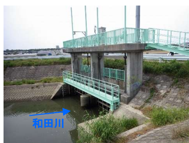
写真 1 - 1 和田川樋門 西川2.8k付近
