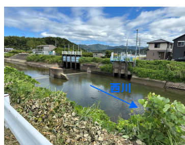
写真 1 - 2 東裏川千貫樋門 西川3.3k付近
