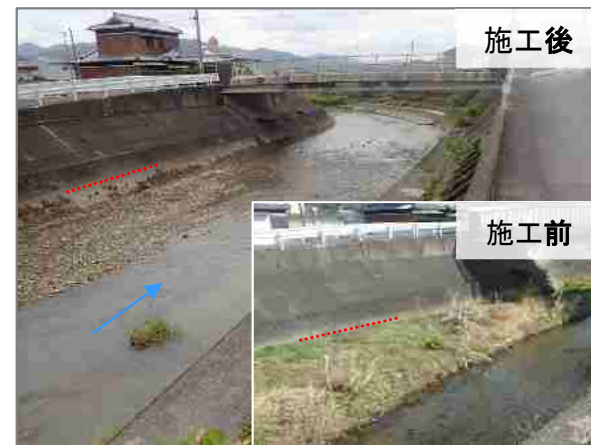
【志賀川 河道掘削 谷口橋付近】
