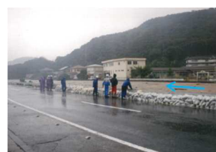
平成13年8月 望見橋より下流付近(0.8k)
