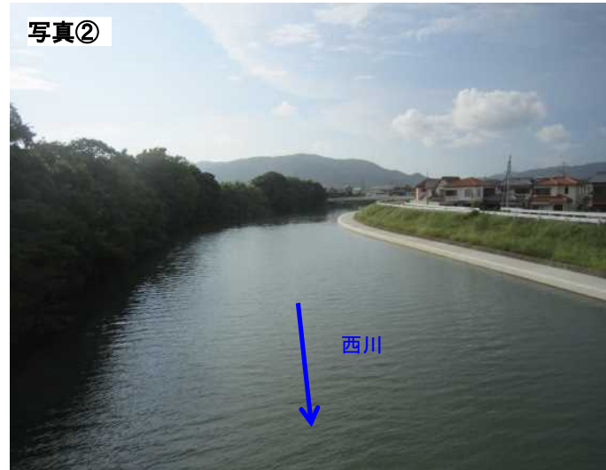
左岸側の矢板護岸が整備済の状況
