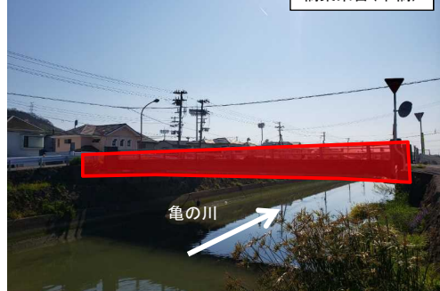
橋梁架替(中橋)
