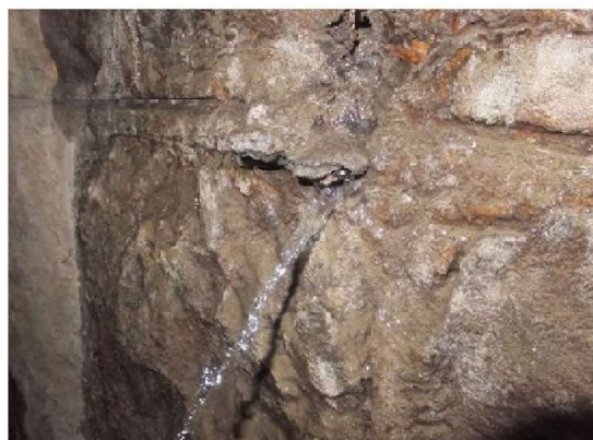
写真-解 7.7 漏水（噴出）している例
