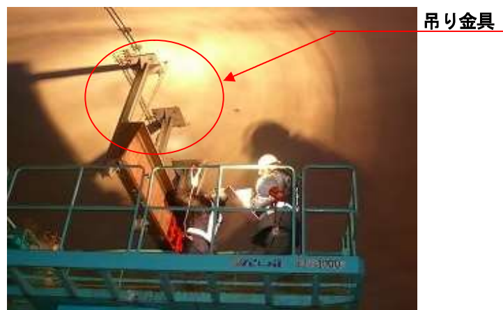
写真-解 6.3 触診作業状況
