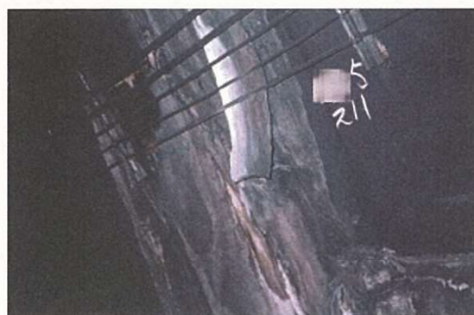
写真-解 7.9 補修モルタルが劣化してはく離している例
