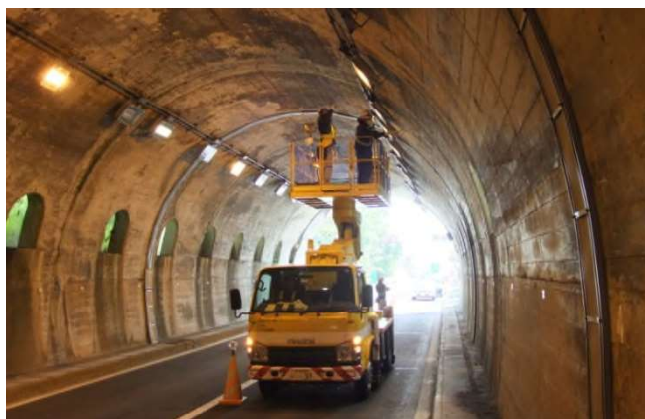
写真-解 6.1 近接目視作業状況
