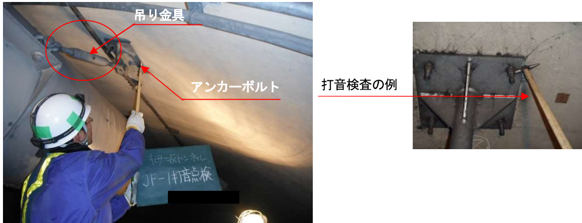
写真-解 6.2 打音検査作業状況
