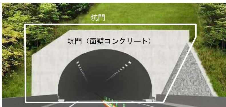
図-7.2 点検対象箇所（トンネル坑口部）
