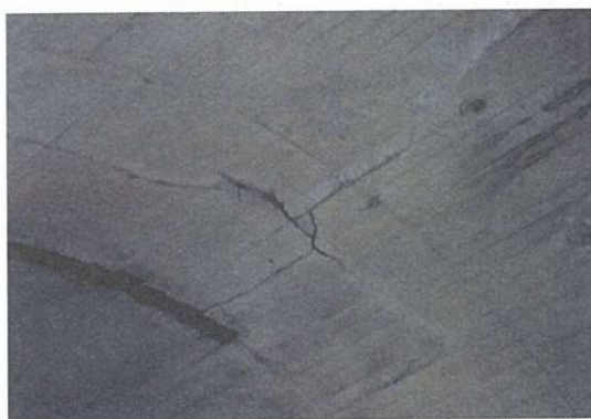
写真-解 7.5 複数のひび割れで覆工コンクリートがブロック化している例
