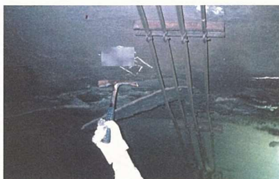
写真-解 7.9 補修モルタルが劣化してはく離している例
