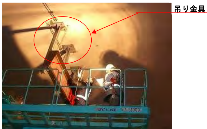
写真－解 3. 3 触診作業状況
