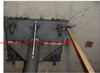
打音検査の例
