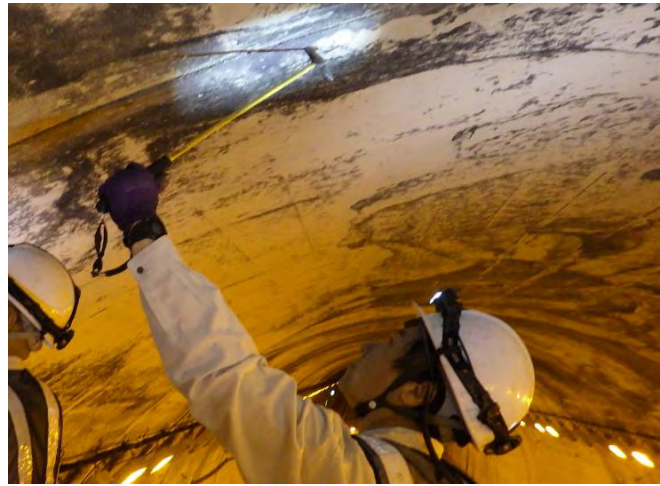
(a) トンネル本体工
