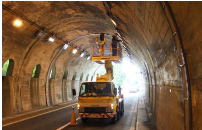
写真一解3.1 近接目視作業状況
