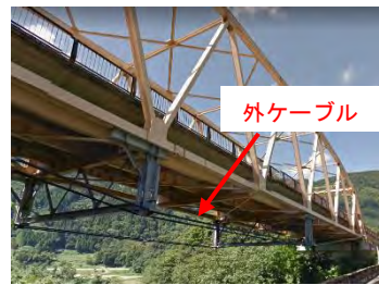
鋼橋の外ケーブル補強の例
