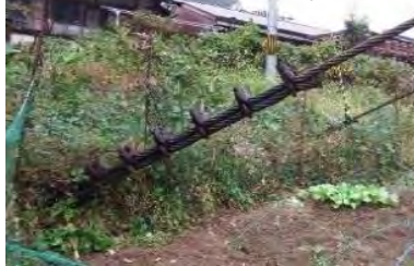
ワイヤークリップによる端末処理
