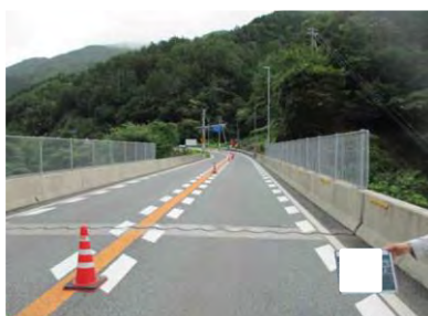
浮き上がりが無いか確認する
