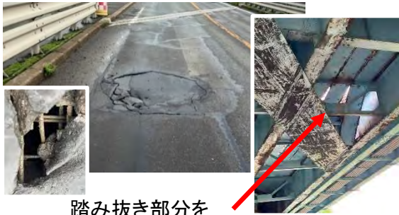
踏み抜き部分をはつり落とした後の床版下面の状況
