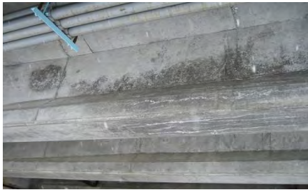
※写真はPC桁下面のひびわれ事例
