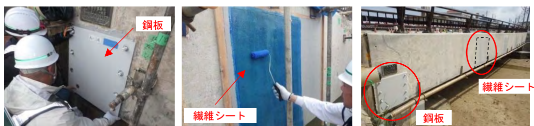
写真 2.3 横締め PC 鋼材の突出防止対策
