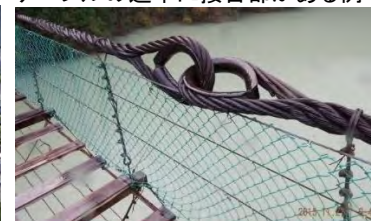
ケーブルの途中に接合部がある例
