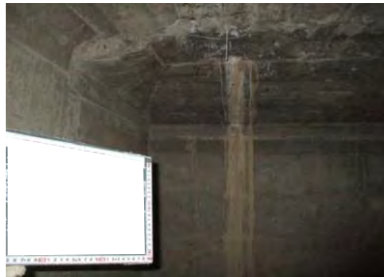
※写真はダブルックバンド橋の箱桁内の状態。
