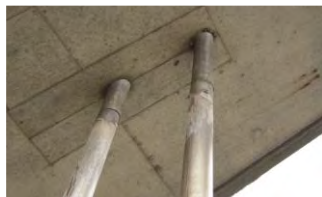
ステンレスの管で保護されている
