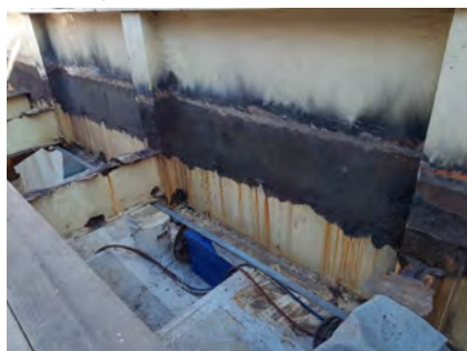
※ 舗装を除去した後の主桁腹板の状態
