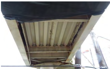
※デッキプレート 横方向の接合部
