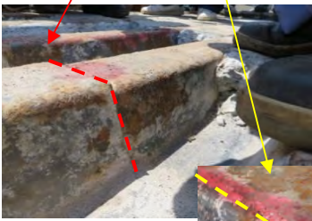
※デッキプレート 方向の接合部
