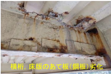
主桁のあて板(鋼板)劣化
