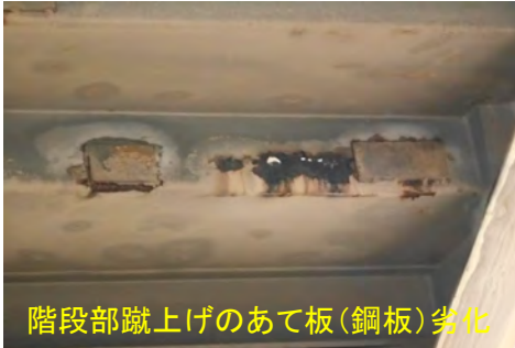
階段部蹴上げのあて板(鋼板)劣化
