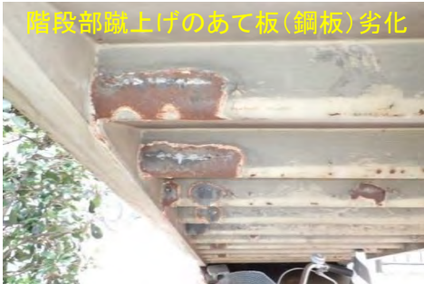
階段部蹴上げのあて板(鋼板)劣化
