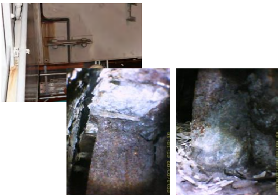
支点上補剛材の状態
