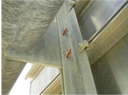
標識板取付部
