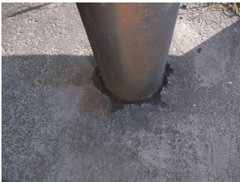
腐食、路面付近での滞水
