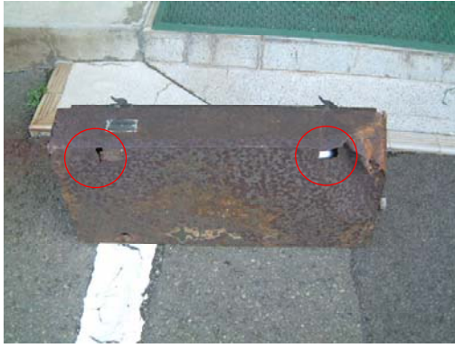
落下照明背面状況
