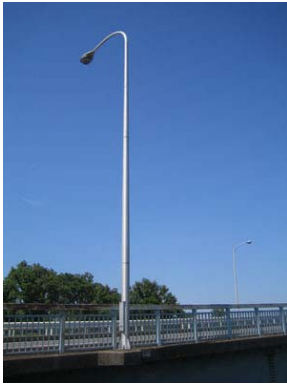
橋梁部に設置
