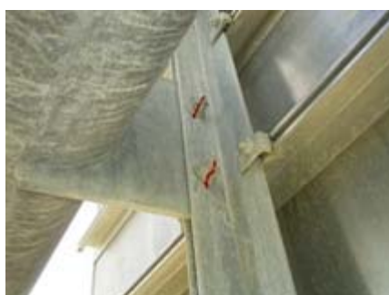
標識板取付部
