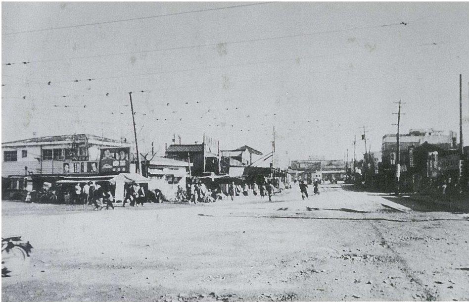
昭和20年台後半 の東和歌山駅前付近
