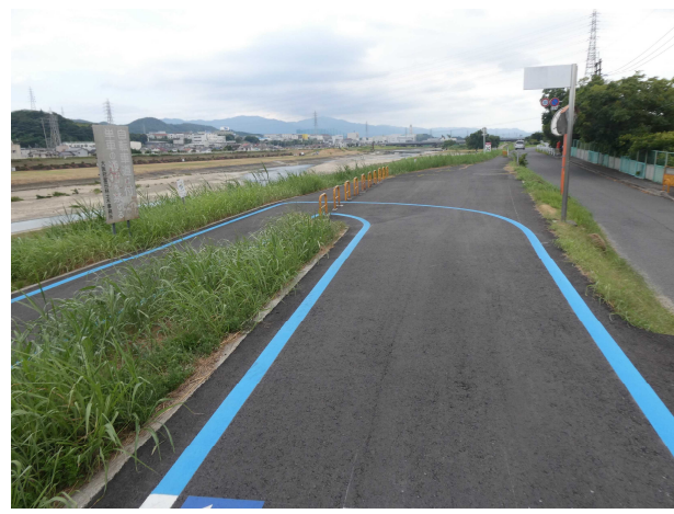
堤防天端から高水敷に移動するスロープ (石川リバーサイドサイクルライン)
