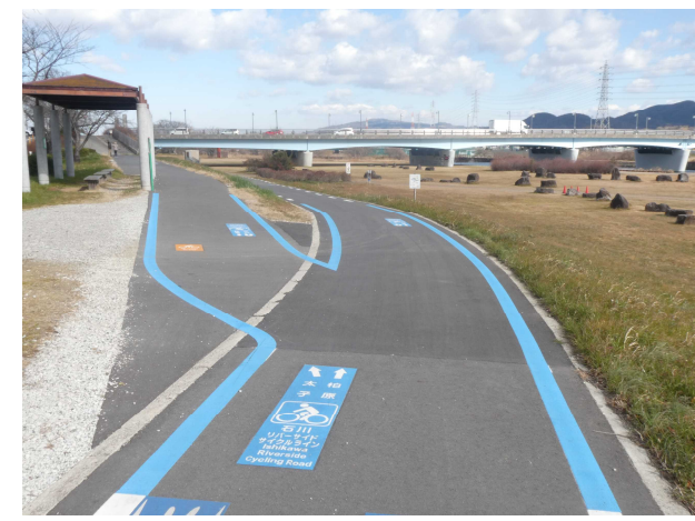
堤防天端から高水敷に移動するスロープ (石川リバーサイドサイクルライン)
