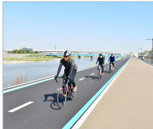
河川空間を活用した自転車歩行者専用道路
