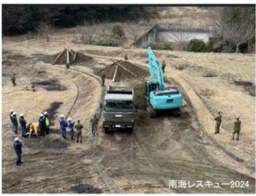
写真 倒壊電柱の撤去訓練(自衛隊連携)
