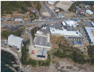
道の駅「すさみ」
