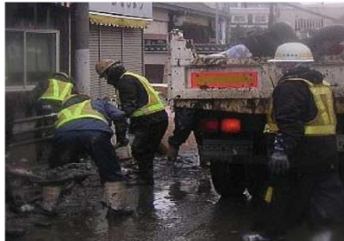
ダンプトラックによる搬出
