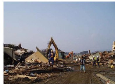
道路脇への山積による車線確保
