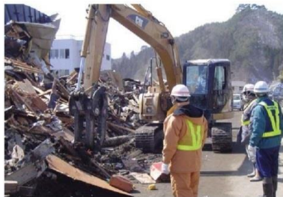
ガレキの撤去作業
