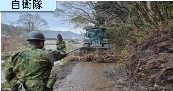
陸自による道路啓開活動
