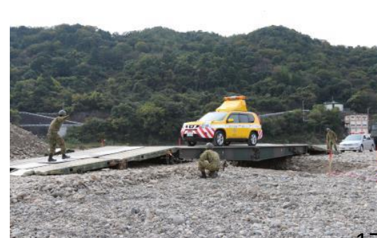
○自走式架柱橋による橋梁復旧
