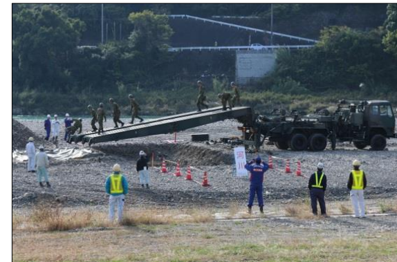
○自走式架柱橋による橋梁復旧
