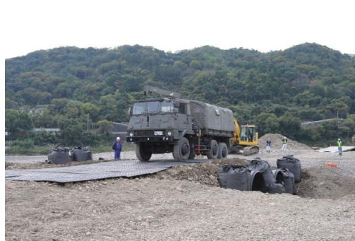
○暗渠排水管による橋梁復旧
