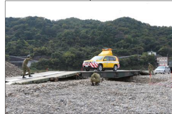
暗渠排水管等による橋梁復旧
