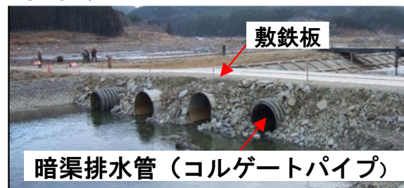
暗渠排水管等による橋梁復旧
