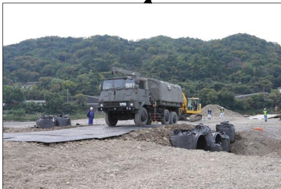
暗渠排水管等による橋梁復旧
