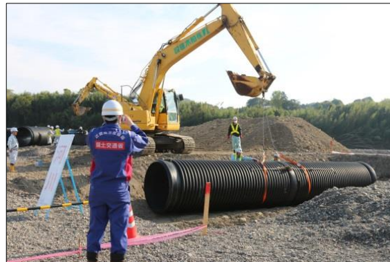
○暗渠排水管による橋梁復旧
