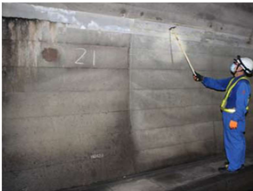
写真 2.5.1 近接目視による定期点検の実施状況
