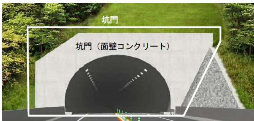
図 2.5.2.2 点検対象箇所（トンネル抗口部）
