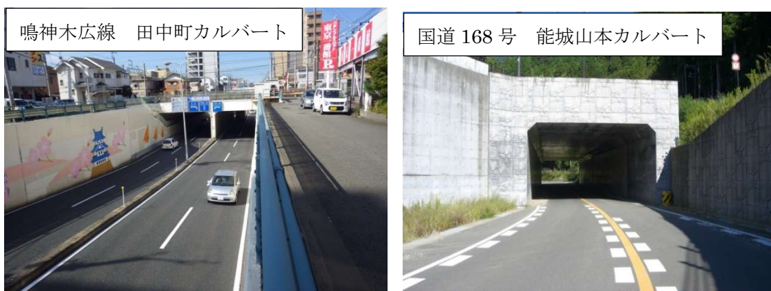
写真 2.3.2 代表的な大型カルバート
