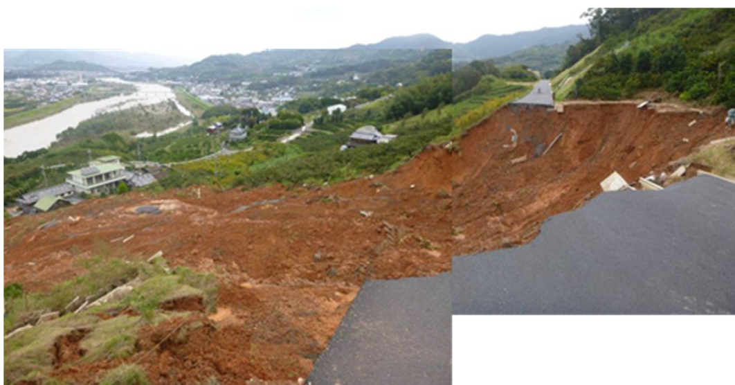
図 1.3 崩壊箇所の状況 (平成 29 年 10 月 24 日撮影)
