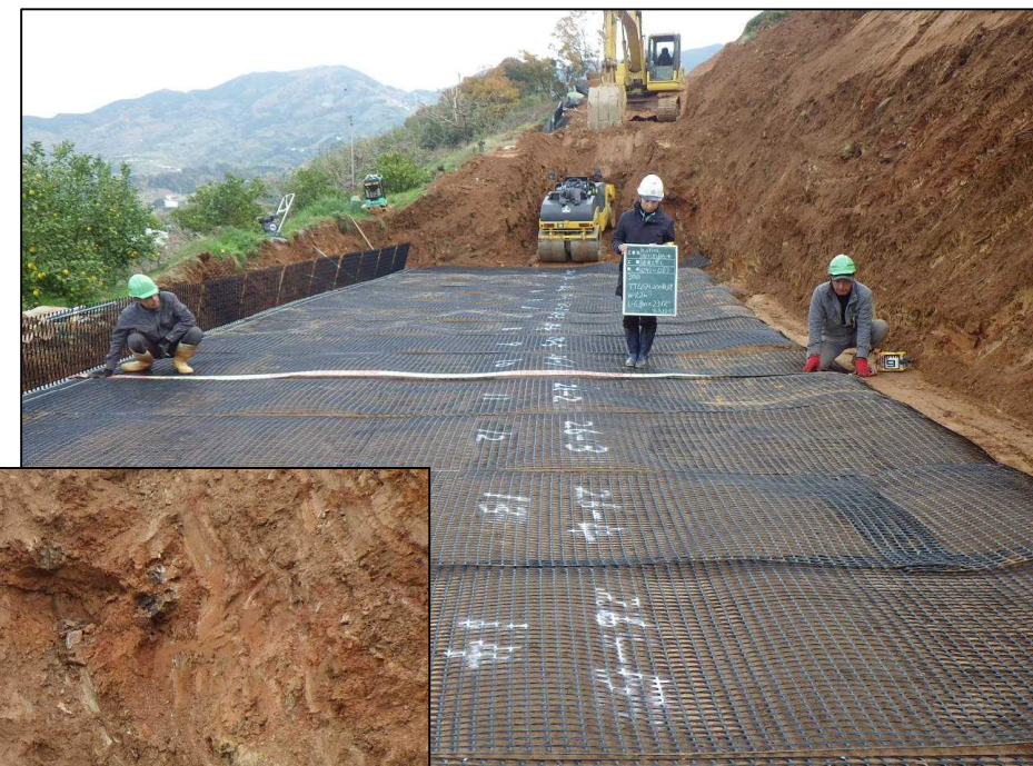
写真 4.6 補強土壁 3 段目（終点側から起点側を撮影）。掘削壁面には褐色化した強風化岩（D層）が分布する。灰白色粘土層は認められない。
