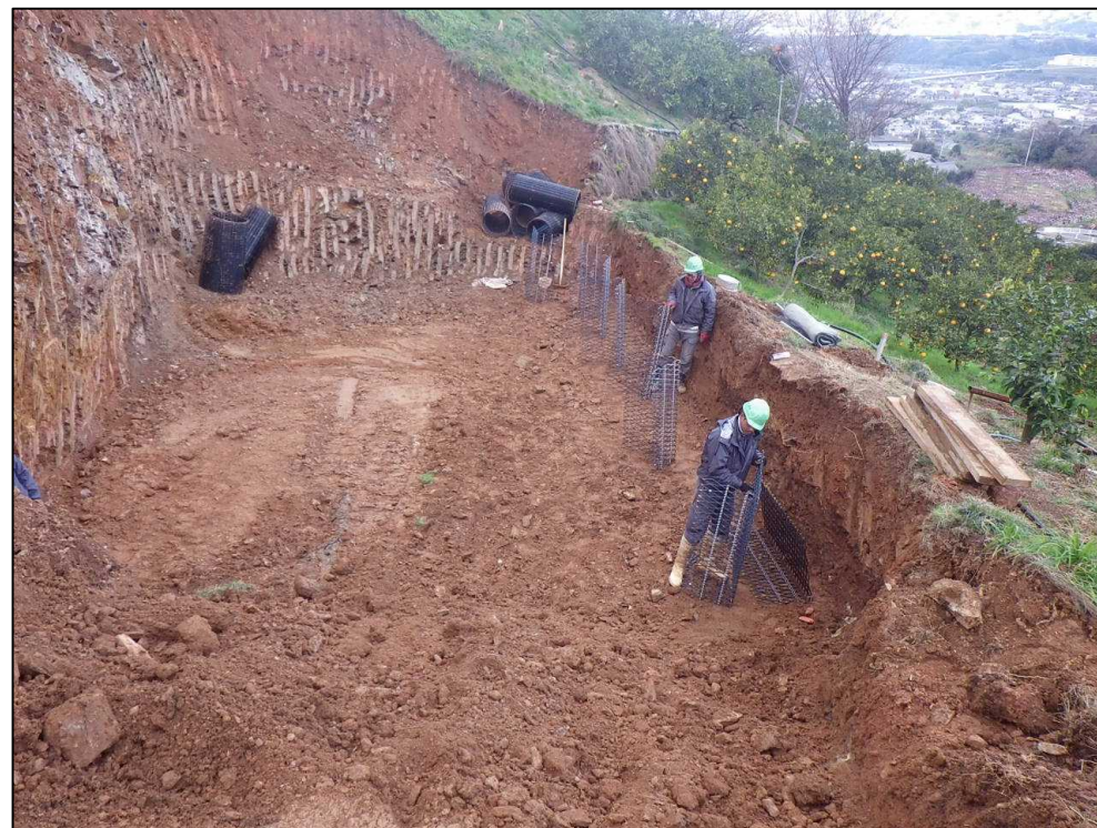
写真 4.5 補強土壁基礎部掘削状況（起点側から終点側を撮影）。掘削底面、掘削壁面には褐色化した強風化岩（D層）が分布する。灰白色の粘土層は認められない。
