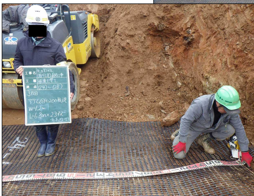
写真 4.7 補強土壁 3 段目起点側壁面の状況。褐色化した強風化岩（D層）が分布する。一部粘土化している部分も認められるが、灰白色粘土層は認められない。
