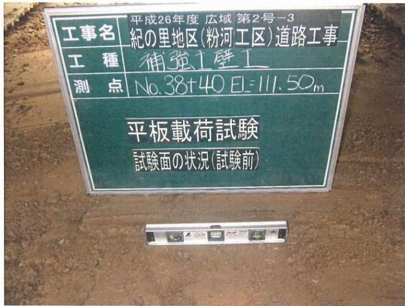
載荷面の状況(試験前)
