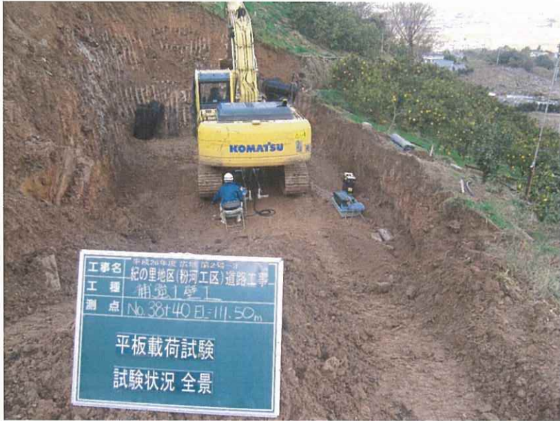
試験箇所全景①
