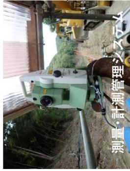
②覆工前の壁面に後視点を設置し、その位置 (XYZ座標) を仮トラバース点に測量・計測管理システムを据えて測定
