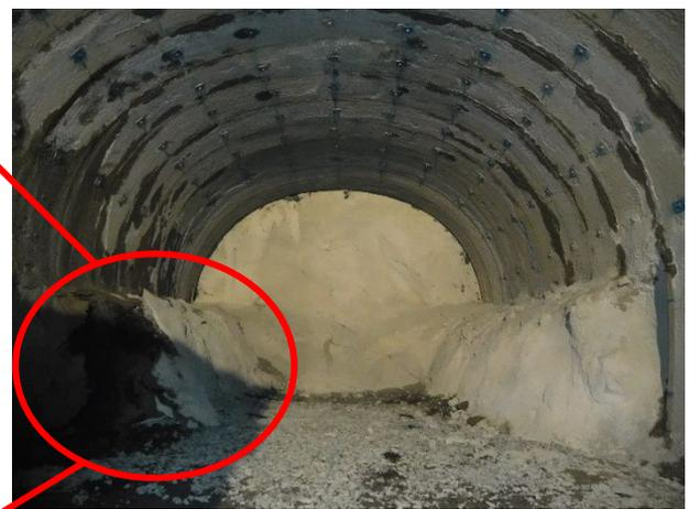
施工状況写真 (左側下半盤に小規模崩壊が発生)
