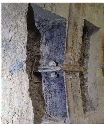
・天端継ぎ手ボルトの締結不良の例 (S034)
