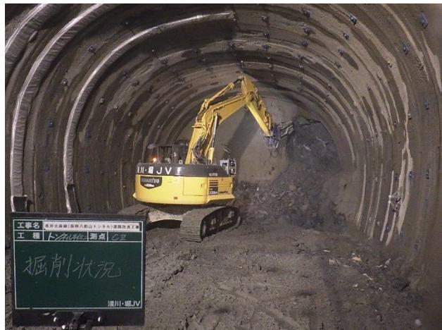
図-4.2.2 掘削方法の変更 大型ブレーカによる掘削状況写真
