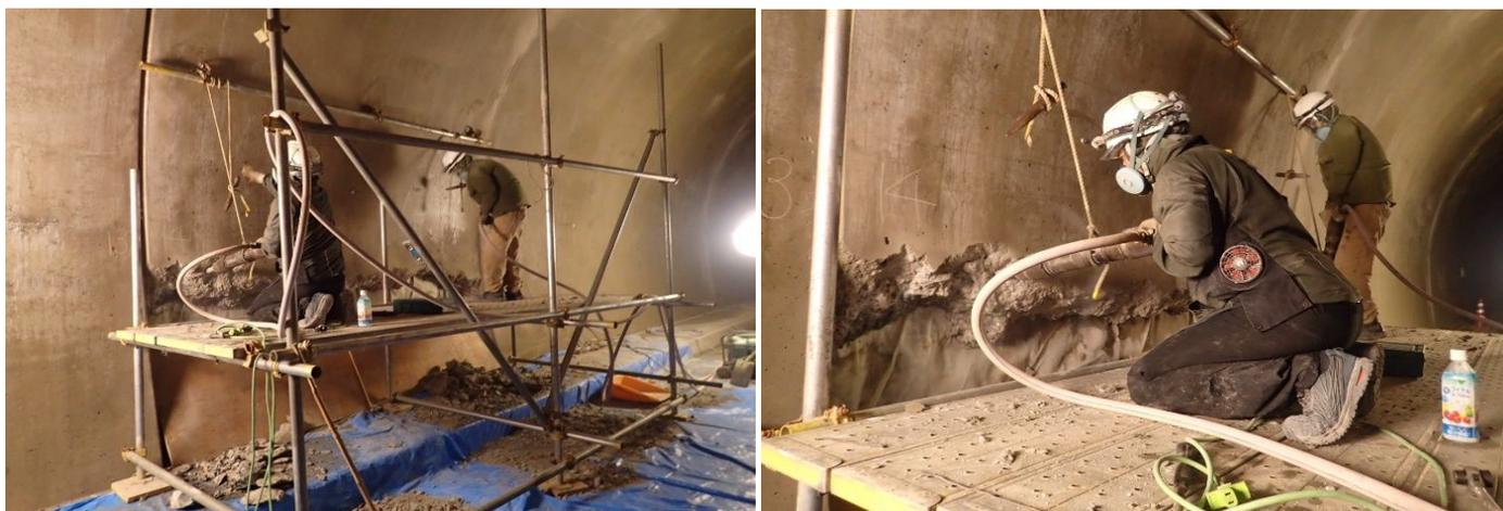
図-3.1.3.1 覆工コンクリートの取壊し状況
