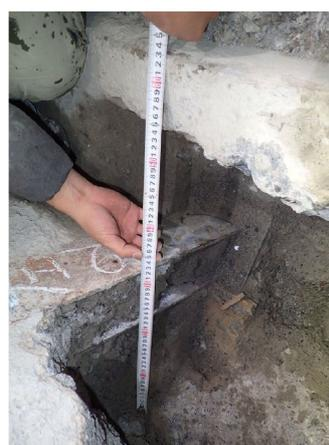
インバート前面から約330mmの位置に鋼アーチ支保工前面がある。
