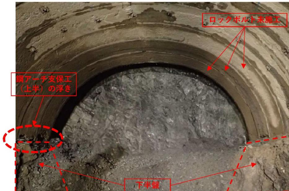
図-4. 4. 3 上半掘削時の下半盤下げ状況
