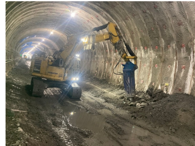
写真-2.1 不適格部撤去 (端部)
