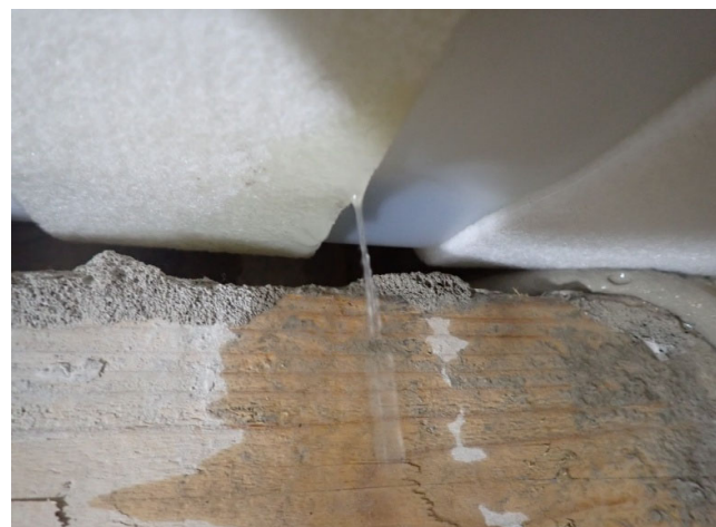
写真-3.18 天端妻部不織布テープによるブリーディング水の排出状況
