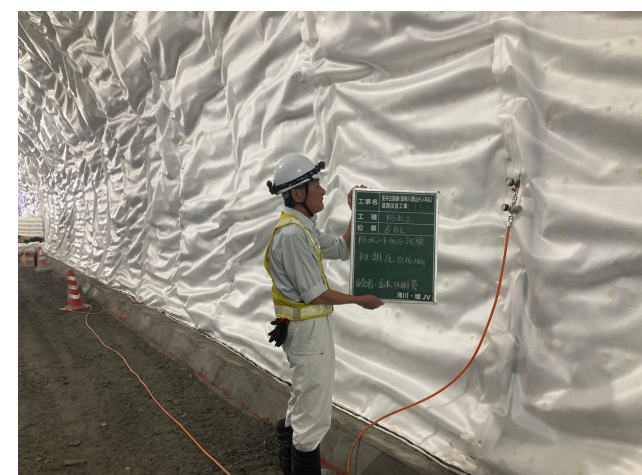
写真-3.31 防水工の加圧試験の立会確認
