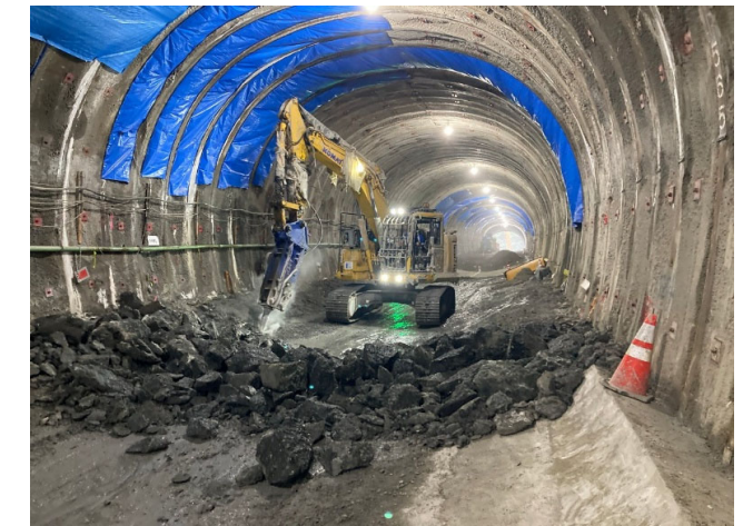
写真-2.4 不適格部撤去
