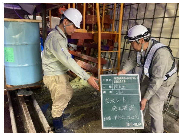
写真-3.11 漏水確認立会状況
