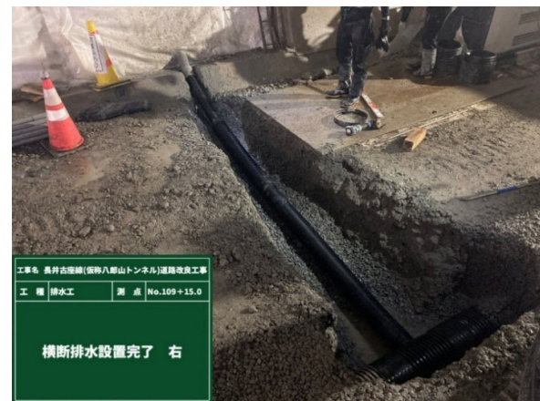
写真-3.10 横断排水工増設状況
