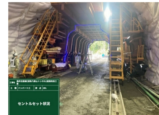
写真-3.14 セントルの調整状況
