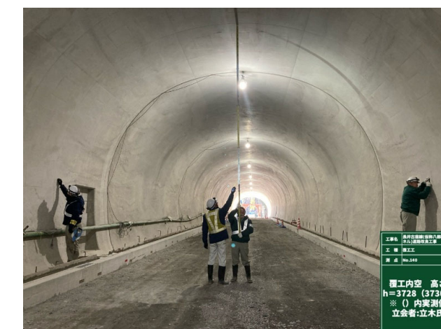
写真-3.26 覆工コンクリート内空の高さ測定状況
