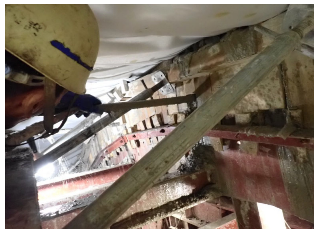
写真-3.16 天端部引抜き式バイブレーターによる締固め状況
