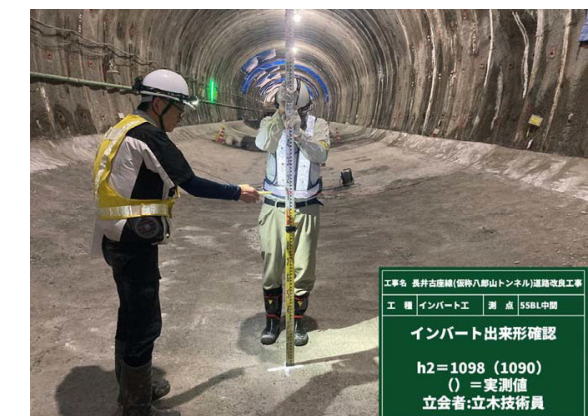
写真-2.9 コンクリート打設後の高さ測定確認状況
