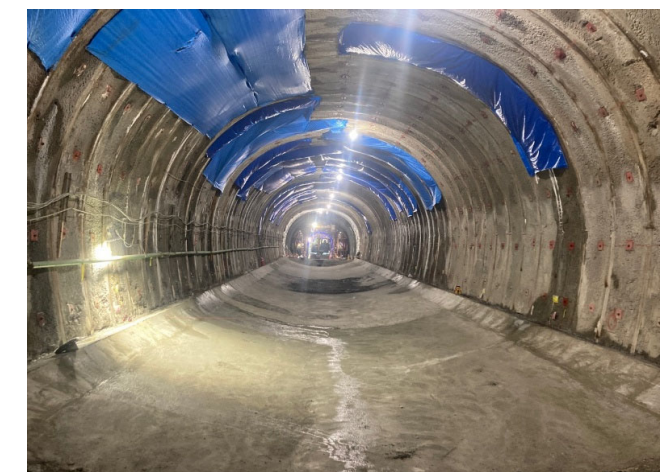
写真-2.6 インバートコンクリート完了
