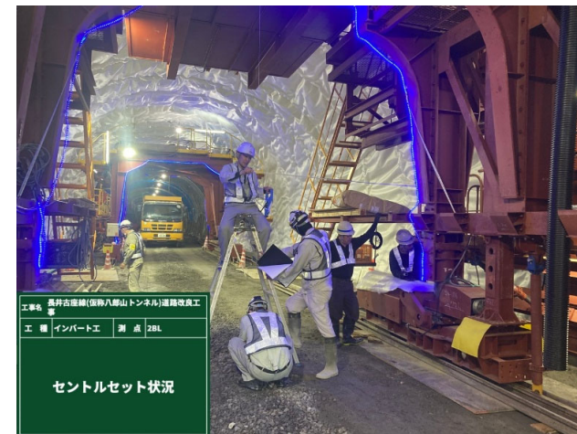
写真-3.2 セトル設置
