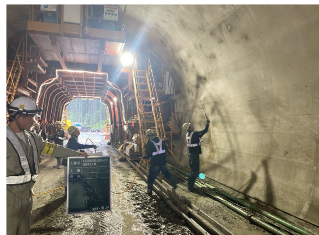
写真-3.23 高性能収縮低減剤の塗布状況
