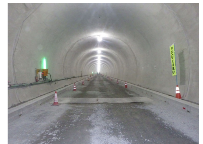
写真-3.6 覆工コンクリート完了
