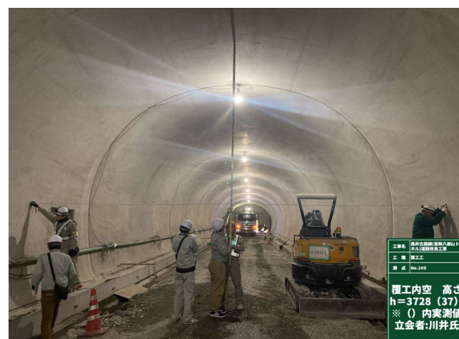
写真-3.30 内空出来形寸法の確認状況
