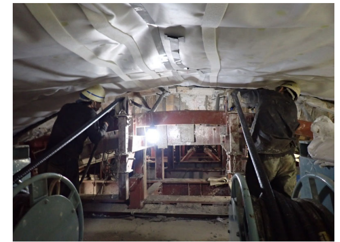
写真-3.5 覆工コンクリート締固め(天端部)
