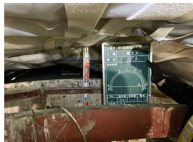
写真-3.27 巻立空間の確認状況
