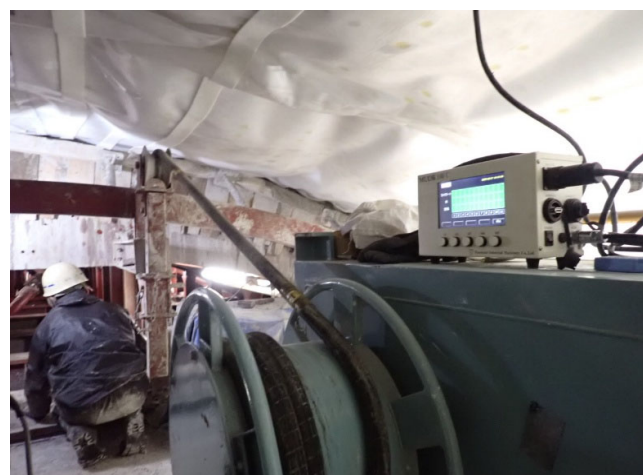
写真-3.17 天端部充填管理システムによる確認状況
