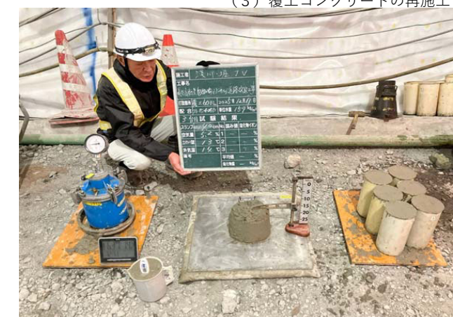
写真-3.32 生コンクリートの品質管理試験の立会確認
