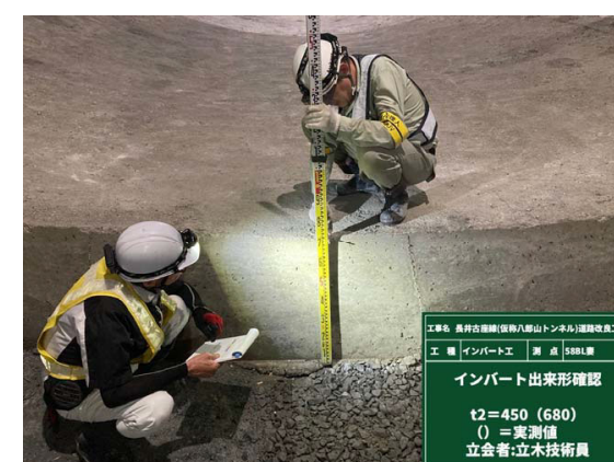
写真-2.8 端面の厚さ測定確認状況
