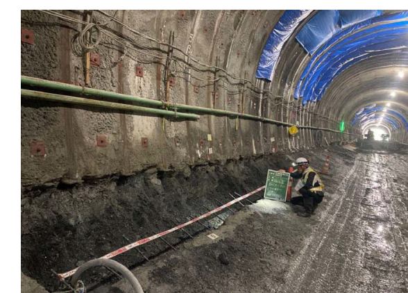
写真-2.10 差し筋アンカー確認状況
