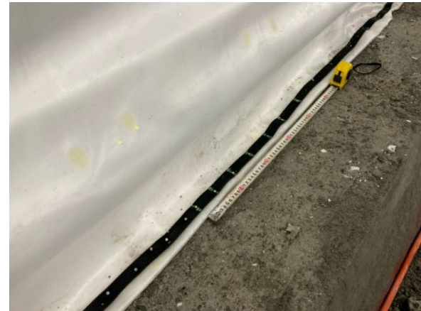
写真-3.9 防水シート端部固定状況
