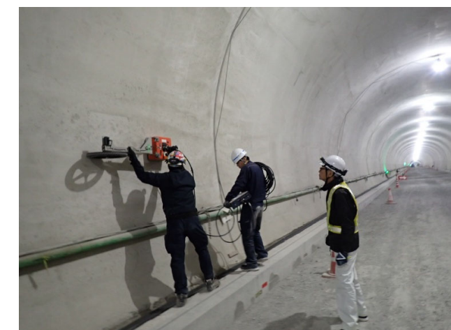
写真-3.34 覆工コンクリート側壁部の調査状況
