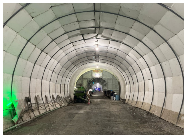
写真-3.22 EPSパネルによる養生状況
