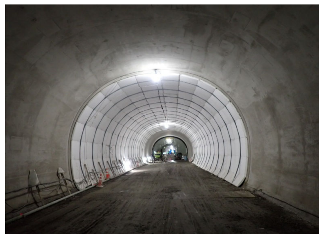
写真-3.21 EPSパネルによる養生状況
