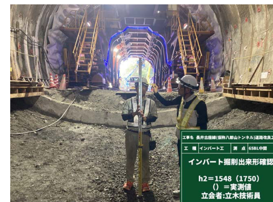
写真-2.7 コンクリート打設前の高さ測定確認状況
