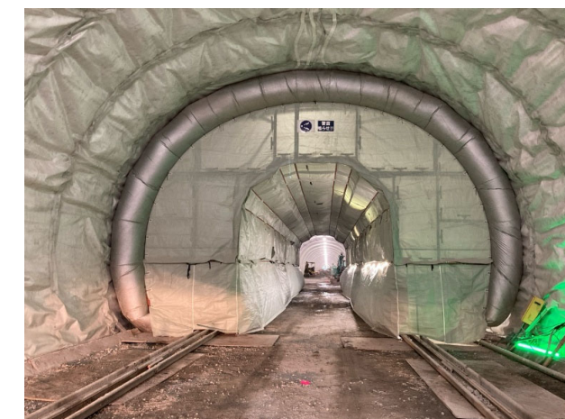
写真-3.20 脱型前養生状況（終点側から撮影）
