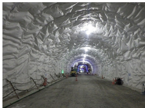
写真-3.8 防水シート完了
