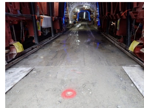
写真-3.13 セントル両妻部センター位置設置状況
