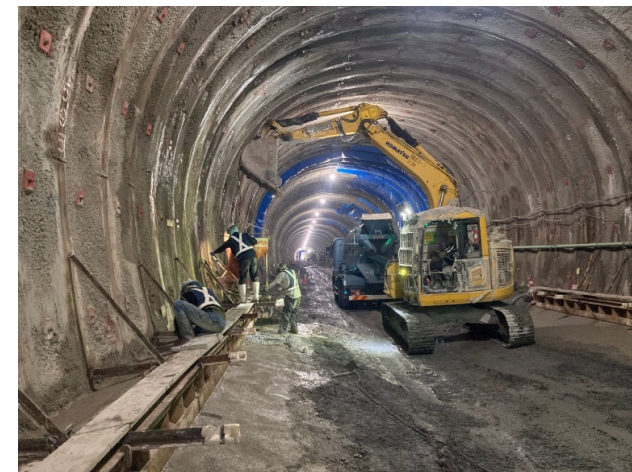
写真-2.2 インバートコンクリート再施工 (端部)
