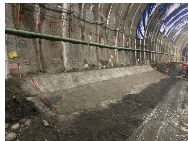
写真-2.3 インバートコンクリート完了 (端部)
