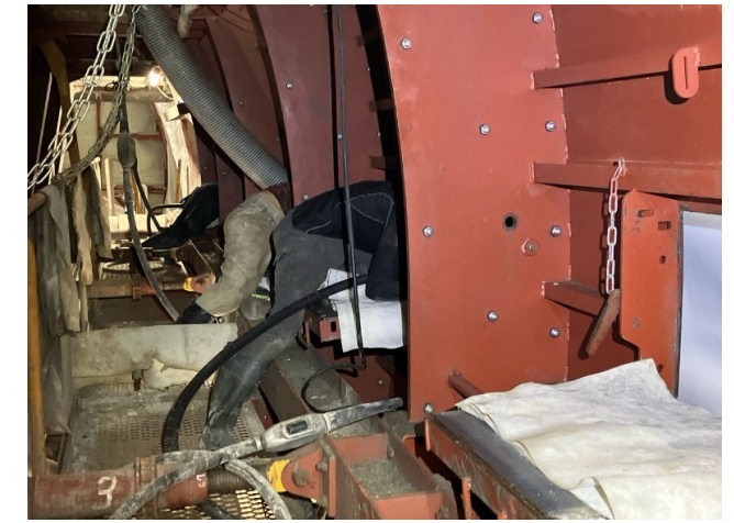
写真-3.4 覆工コンクリート締固め(側部)
