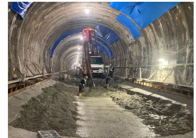
写真-2.5 インバートコンクリート再施工
