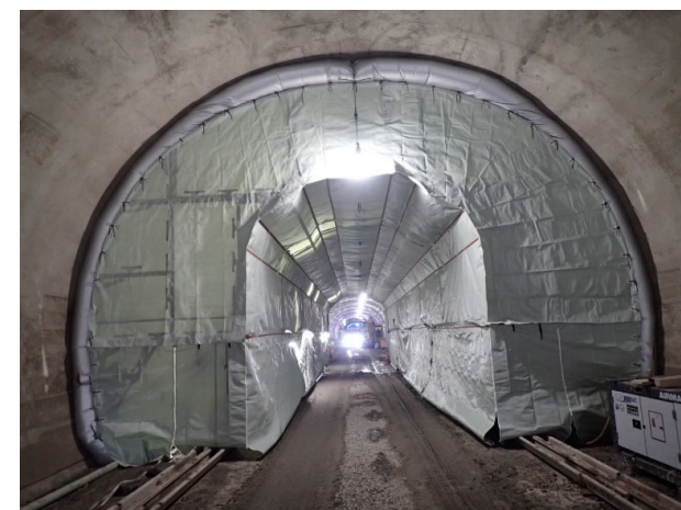
写真-3.19 脱型前養生状況（起点側から撮影）
