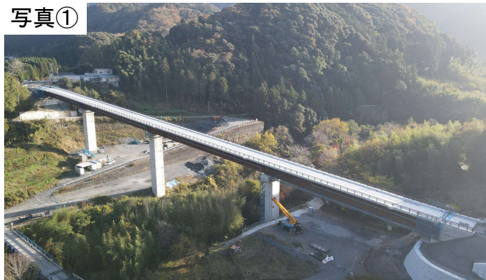
令和4年11月30日時点(施工状況)
