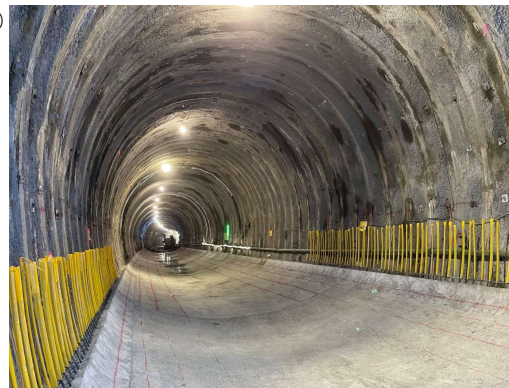
令和4年12月31日時点(施工状況)
