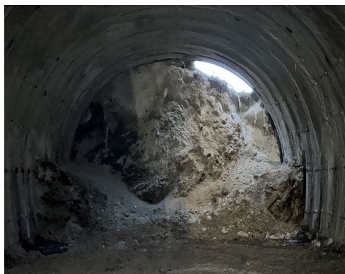
令和4年11月30日時点(施工状況)
