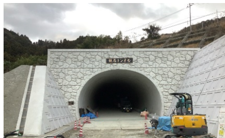
令和7年2月末現在（施工状況）
