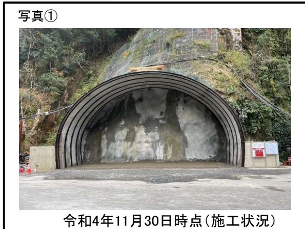
工事状況写真
