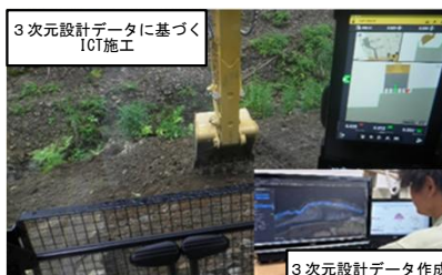
ICT活用工事 （3次元設計データ及びICT建機による施工）
