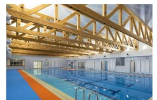
障害児者サポートセンター屋内プール
