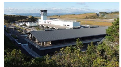
国際線ターミナルビル
