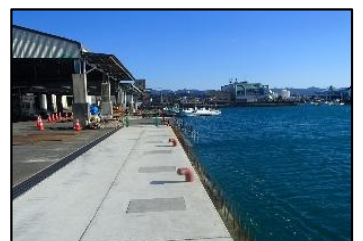
岸壁の耐震化（田辺漁港）
