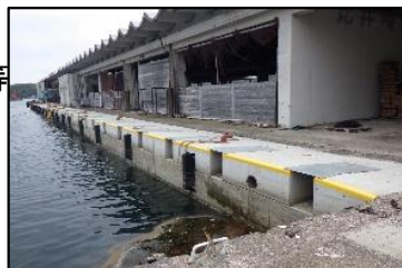
岸壁の耐震化（阿尾漁港）
