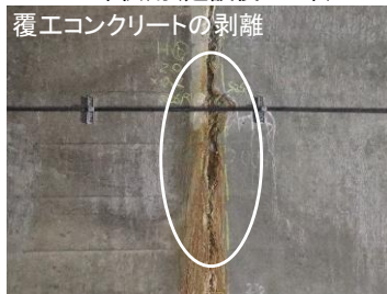
すさみ古座線 獅子目トンネル 1983年供用(建設後42年)
