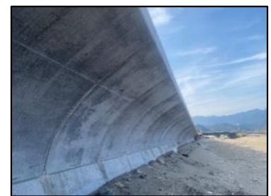
津波避難困難地域解消のための整備 （那智勝浦海岸）
