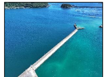
防波堤の改良（串本漁港）
