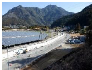
熊野川(輪中堤)整備状況
