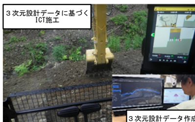
ICT活用工事 （3次元設計データ及びICT建機による施工）
