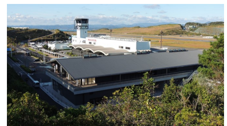
国際線ターミナルビル
