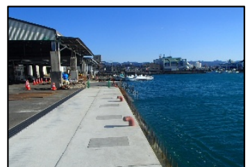
岸壁の耐震化（田辺漁港）
