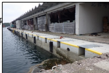
岸壁の耐震化（阿尾漁港）
