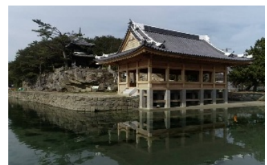
和歌公園「観海閣」の復元的整備 （2026年3月竣工）
