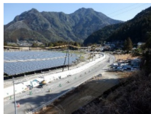
熊野川(輪中堤)整備状況
