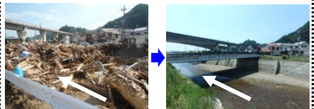
災害復旧助成事業によって復旧した那智川(2011年発生災害)
