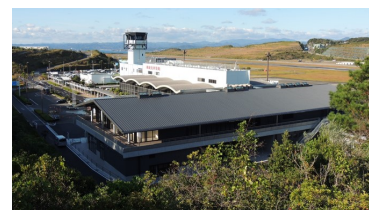
国際線ターミナルビル
