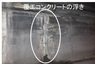
国道371号 紀見隧道 1969年供用(建設後55年)
