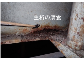
和歌山阪南線 松江横断歩道橋 1968年供用(建設後56年)
