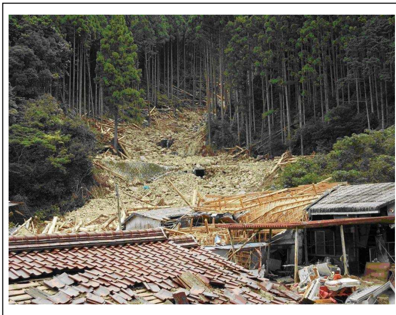
被災時の状況
