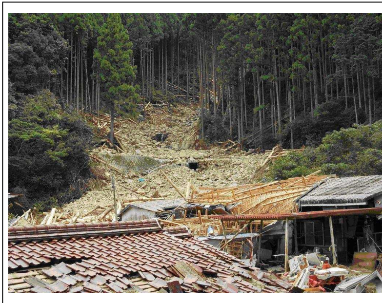
被災時の状況
