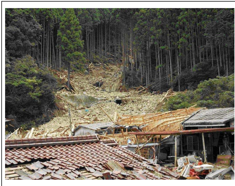
被災時の状況
