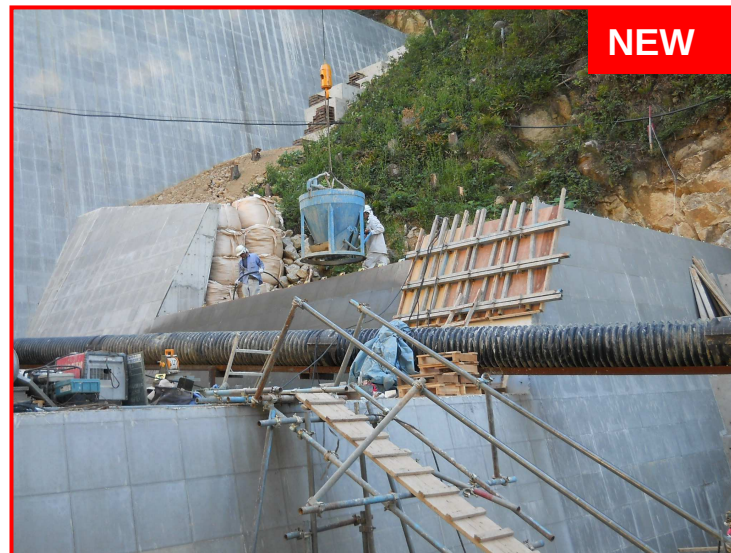
前庭保護工コンクリート打設
