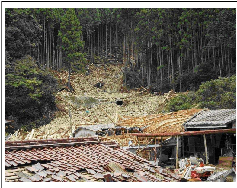
被災時の状況
