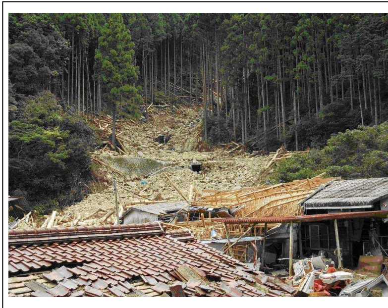
被災状況写真
