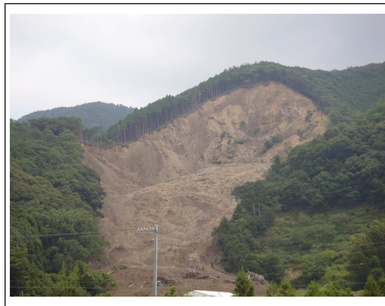
伐木および仮排水工 完成
