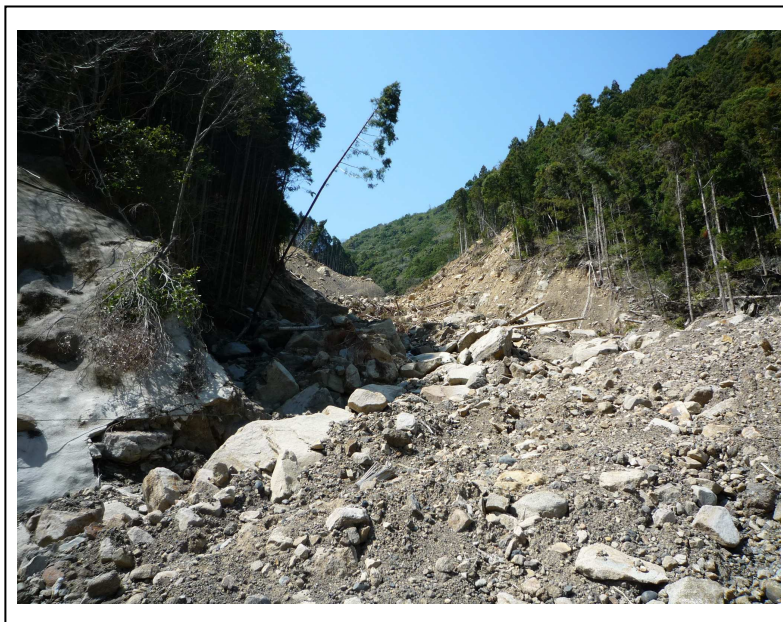
被災状況写真
