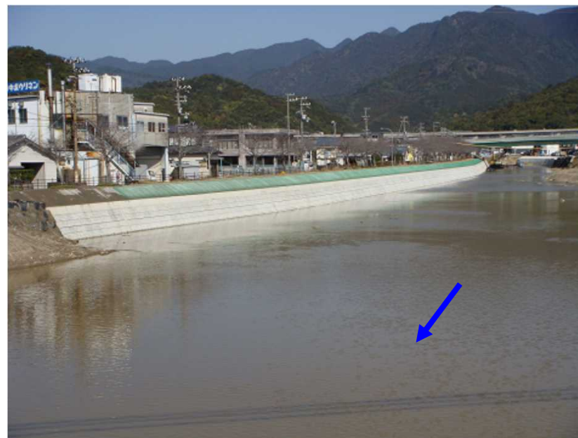
現況写真(改良復旧箇所)
