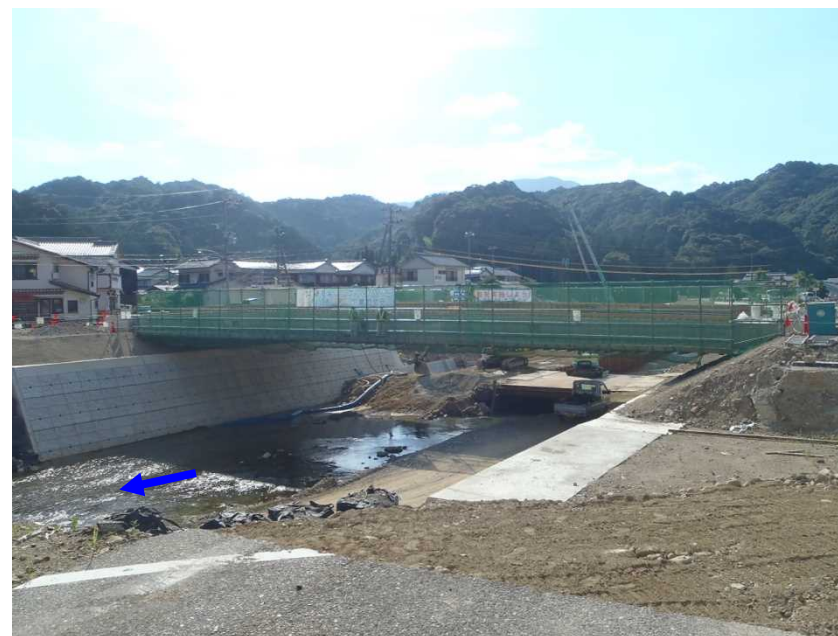
現況写真(改良復旧箇所)
