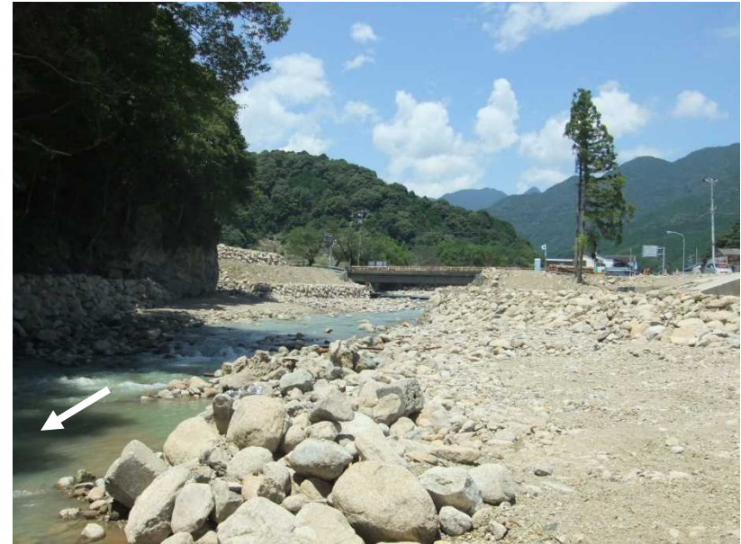
現況写真(応急復旧箇所)
