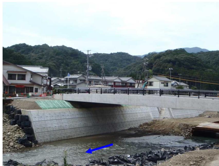
現況写真(改良復旧箇所)
