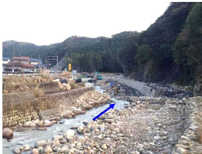
現況写真(改良復旧箇所)
