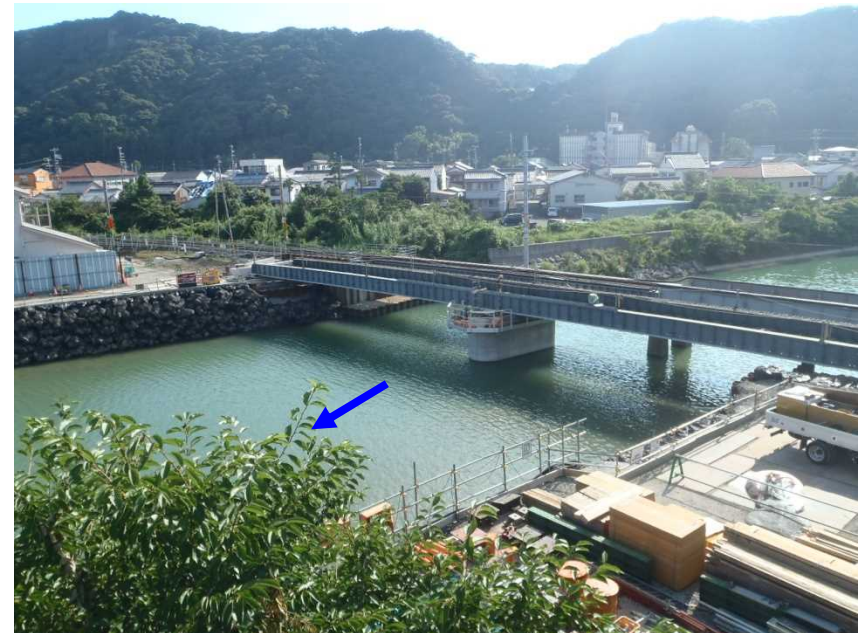
現況写真(改良復旧箇所)
