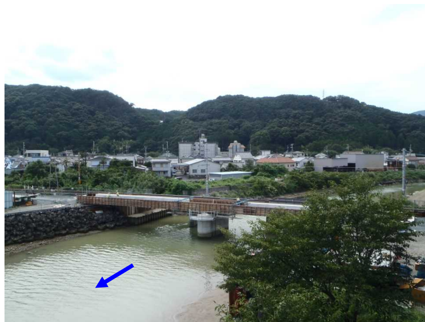
現況写真(改良復旧箇所)
