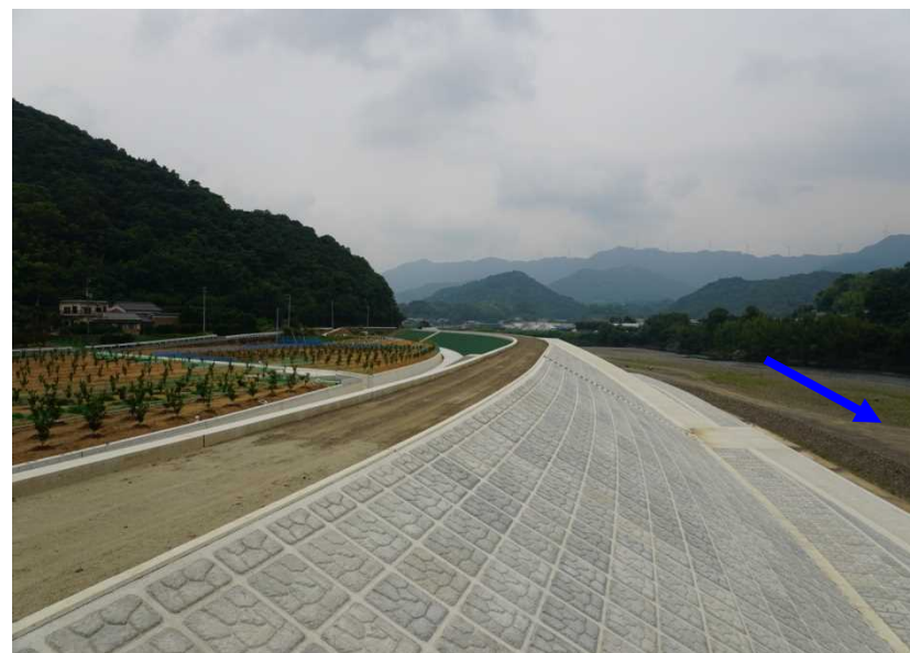
現況写真(改良復旧箇所)
