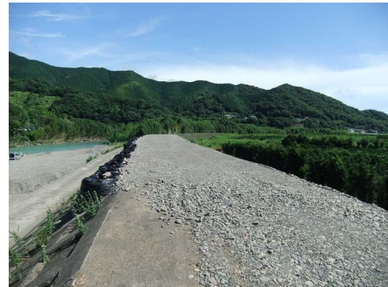
現況写真(原形復旧箇所)
