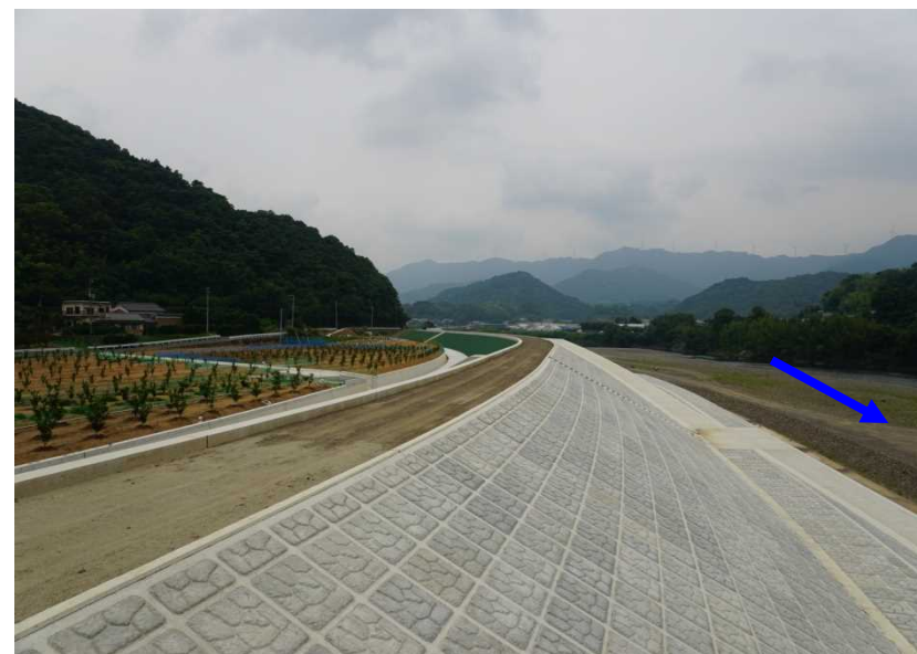
現況写真(改良復旧箇所)
