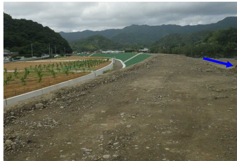
現況写真(改良復旧箇所)
