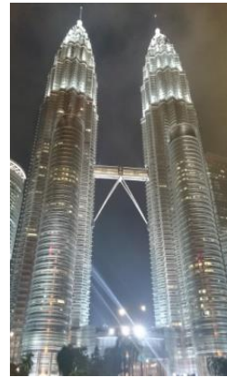
ペトロナスツインタワー (ランドマーク)
