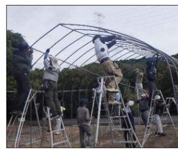
パイプハウス建設実習
