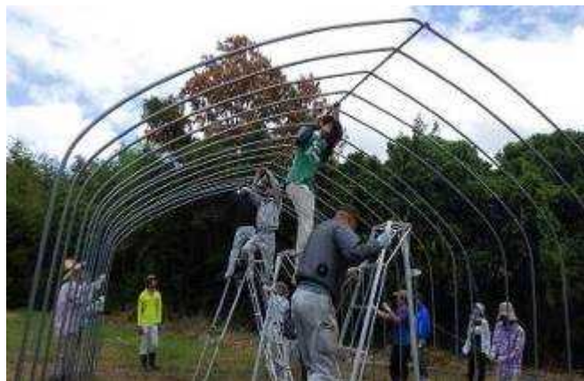
パイプハウスの建設実習
